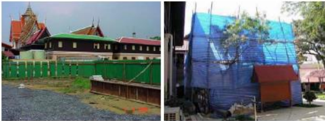
รูปที่ 1-1 ตัวอย่างรั้วกันเขตก่อสร้าง
